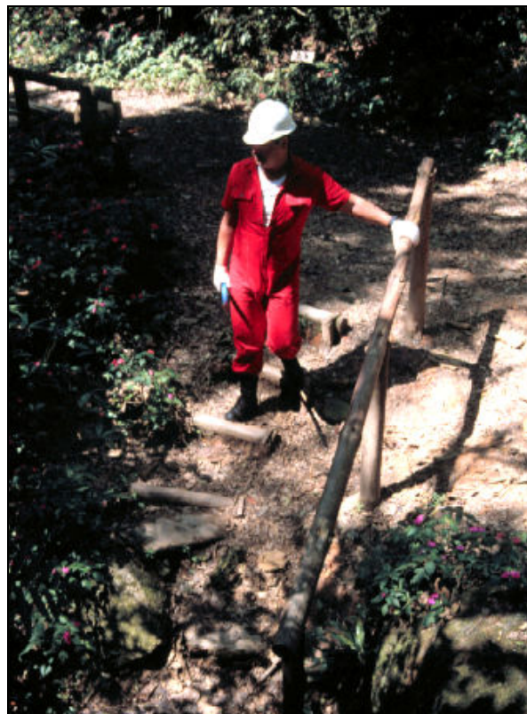
Figura 9 - Detalhe de corrimão e degraus observados no Parque Estadual da Cantareira, SP (foto do autor).
