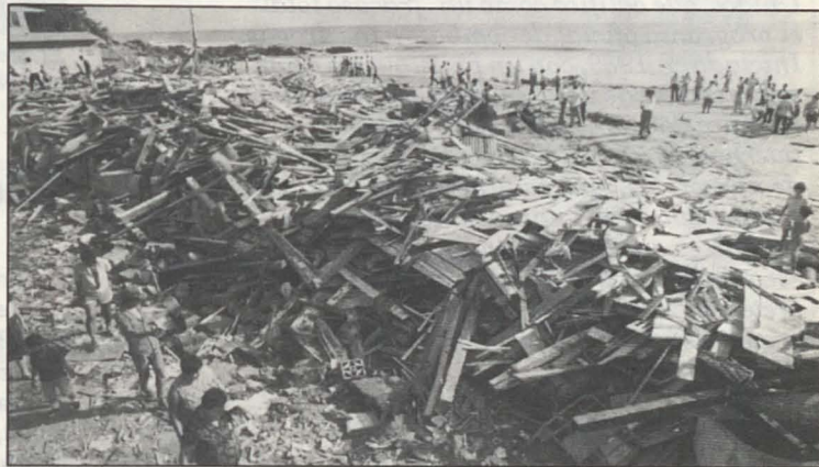
Vecinos del balneario de Casares inspeccionan las ruinas de un hotel
