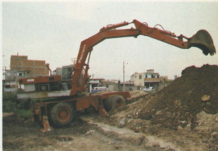
Obras de saneamiento básico - (Brasil)
