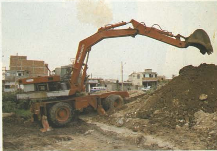
Obras de saneamiento básico - (Brasil)
