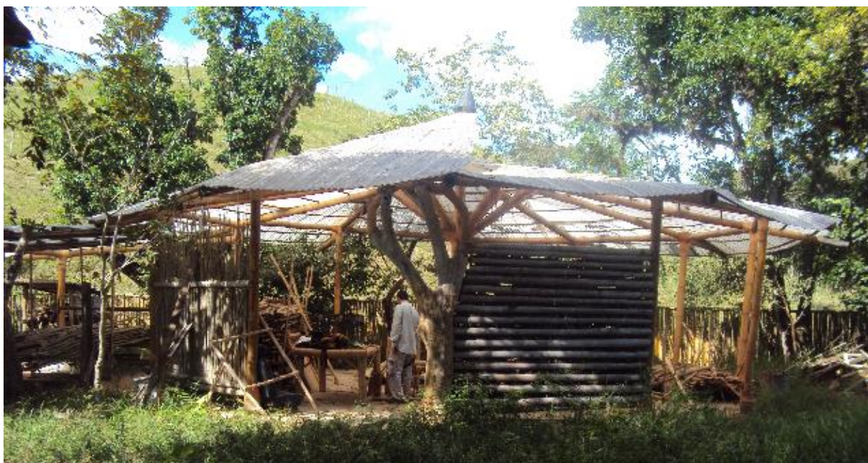
Figura 3: Dodecaedro construído com Dendrocalamus sp. , sítio Mel Bambu. (foto: Ivan lobo)
