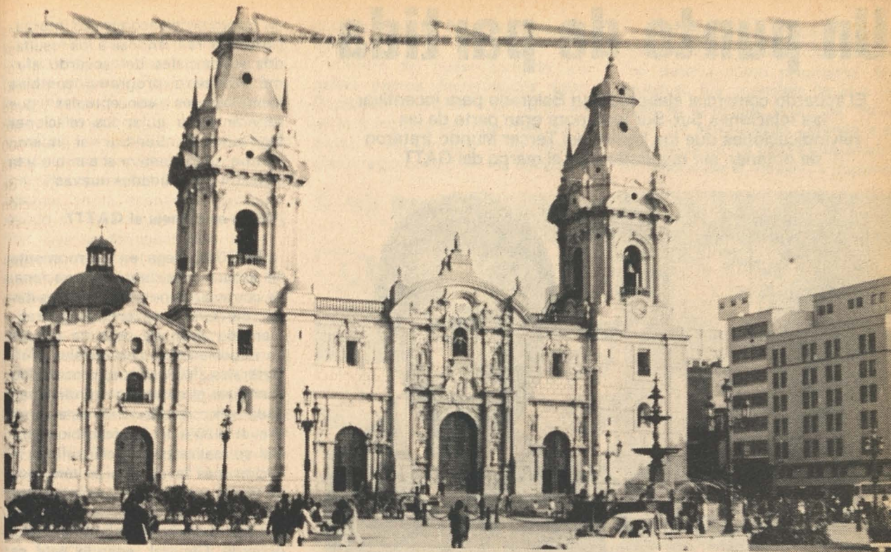
La bella y antigua Catedral de Lima (Perú) es la mayor construcción de barro del mundo, hecha con ladrillos de adobe, sin refuerzos
