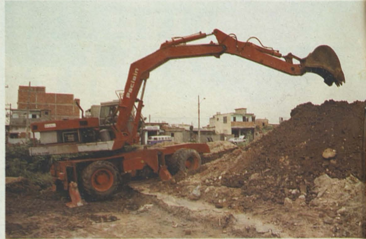
Obras de saneamiento básico - (Brasil)
