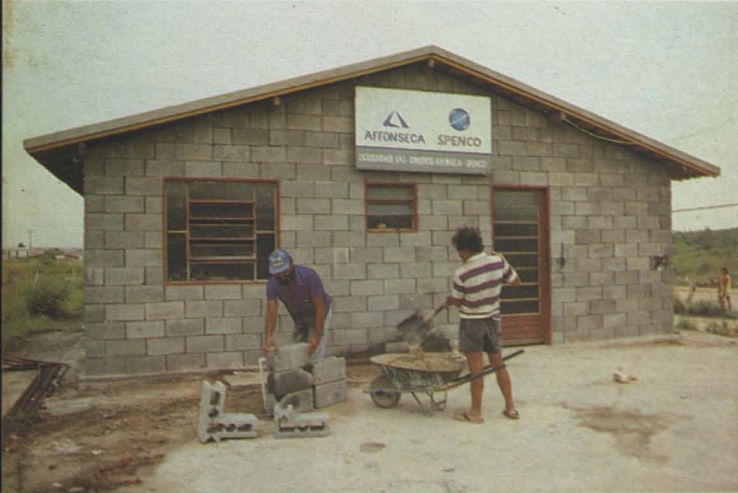
Construcción de habitaciones por el sistema TRAVA-BLOCOS - Brasil
