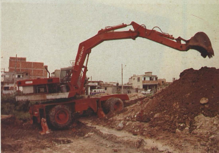
Obras de saneamiento básico - (Brasil)
