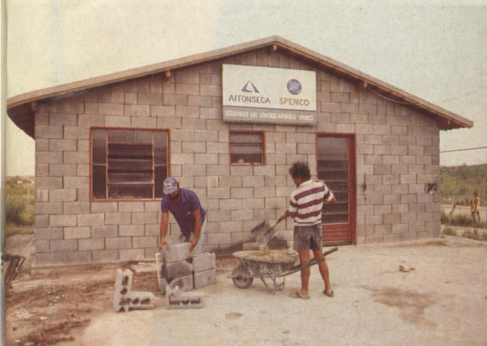
Construcción de habitaciones por el sistema TRAVA-BLOCOS - Brasil
