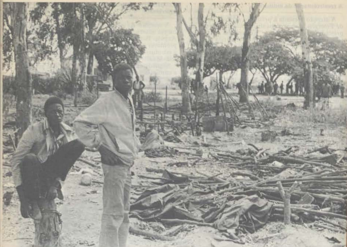
A ocupação sul-africana no sul de Angola causa diariamente sérios danos à infraestrutura econômica e social do país
