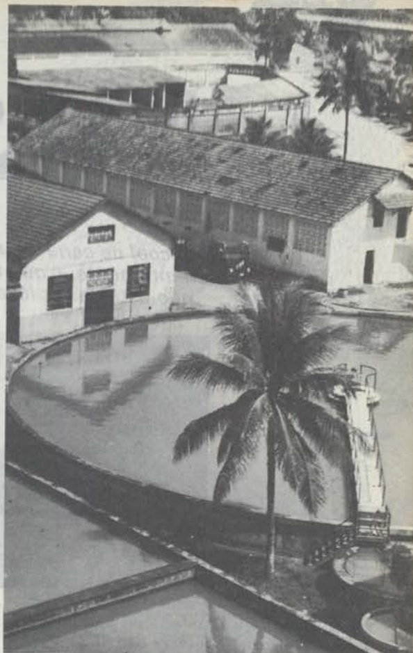
Reservatório de água para a mistura com caldo de cana
