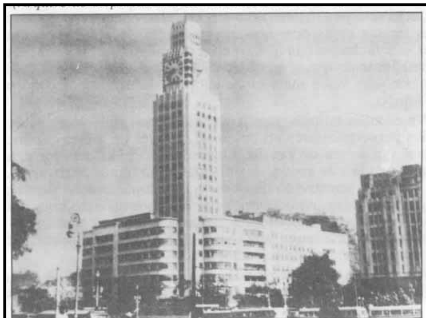
Figura 3. Prédio da Central do Brasil (atual Edifício D. Pedro II), projeto R.M. Carvalho, Adalberto Szilard e Geza Heller, 1937. (Arquivo do Departamento de Patrimônio da CBTU)
