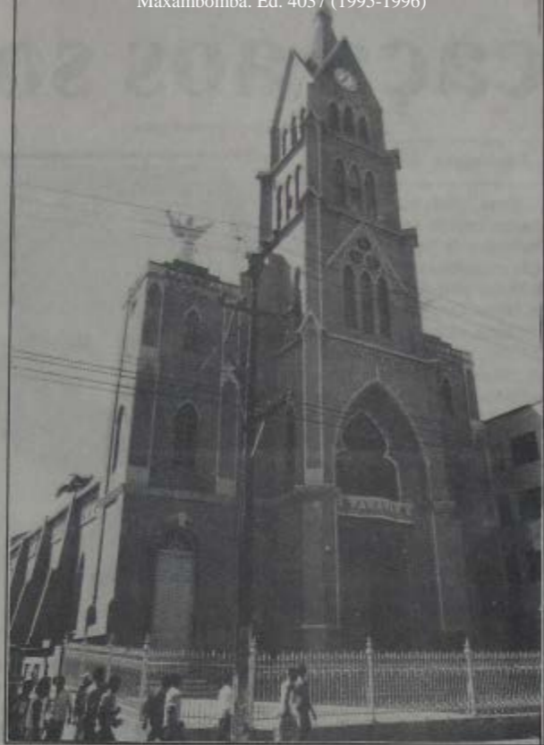
Sobre a arquitetura de 1863 (original), a nova Matriz de Santo Antonio de Jacutinga recebeu, na década de trinta, o torreão central, e sobre as torres laterais (duas) os anjos (de concreto).
