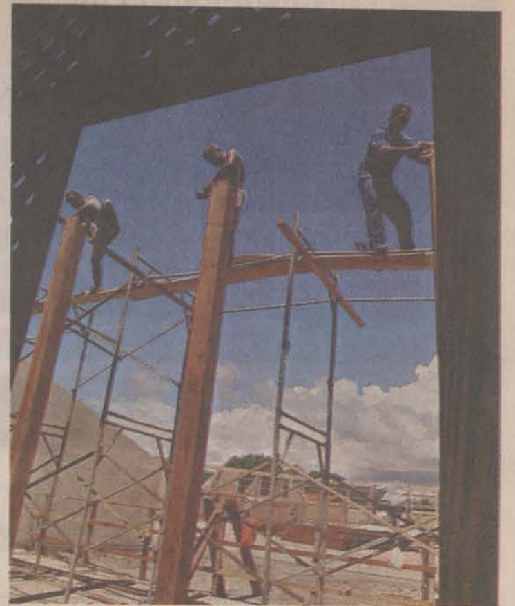
Obras do Pataxopping, que abrigará as lojas de artesanato
