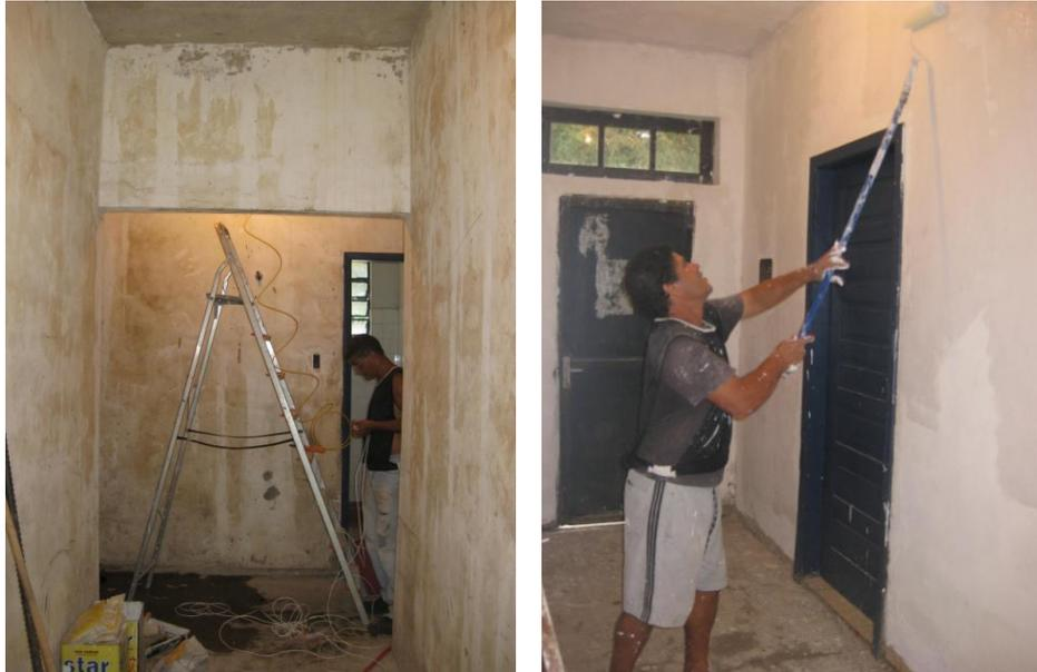
**Figura 14:** Instalação elétrica e pintura do corredor.
