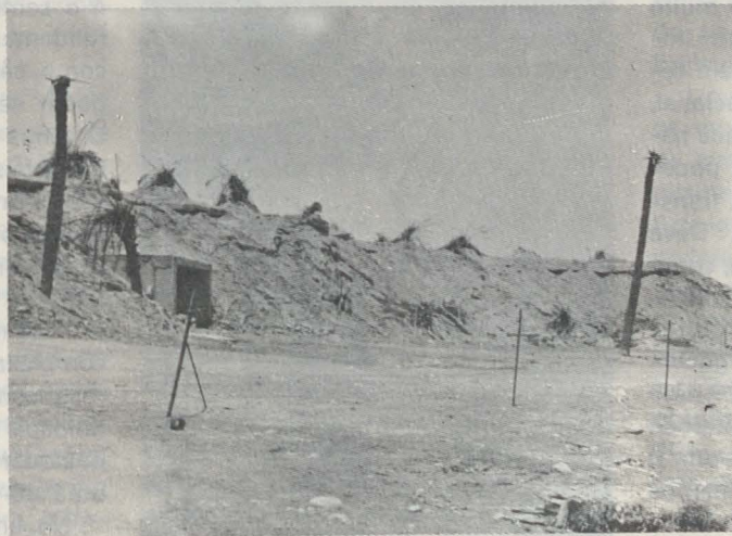
Em Fao, a entrada de hospital subterrâneo deixado pelos iranianos
