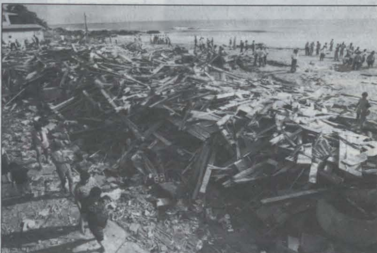
Moradores do balneário de Casares inspecionam as ruínas de um hotel
