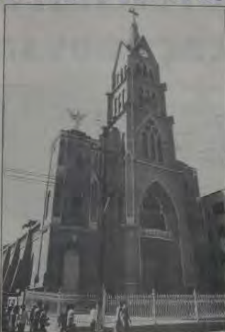
Sobre a arquitetura de 1863 (original), a nova Matriz de Santo Antonio de Jacutinga recebeu, na década de trinta, o torreão central, e sobre as torres laterais (duas) os anjos (de concreto).
