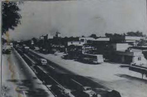
Os proprietários de imóveis situados à margem da Presidente Dutra apostam na privatização, considerando que o abandono da principal rodovia do País vem prejudicando, há muitos anos, muitas empresas instaladas ao longo do seu curso.
