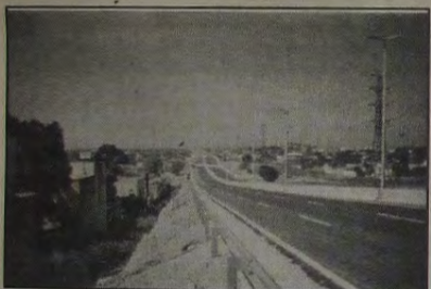
Trecho da Via Light, na altura do bairro Vila Emil
