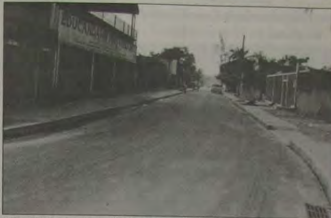
A Rua Espinhares, no Bairro São José, foi saneada, drenada e pavimentada.
