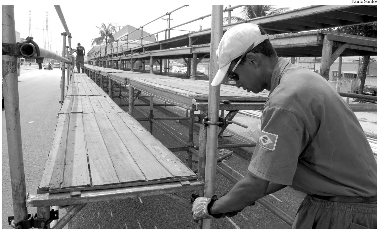
As arquibancadas para os desfiles do Carnaval foram montadas na Via Light, no trecho que vai da Rua Cel. Francisco Soares até a esquina da Rua Prof. Paris
