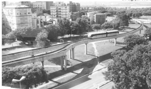
O passo inicial para a implantação do projeto será a instalação de 4,5 km de plataformas suspensas com cerca de sete metros de altura e a construção de oito estações no Centro para possibilitar a circulação do Aeromóvel
