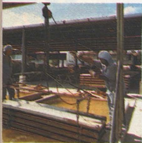
Pórticos - Fábrica do RJ
