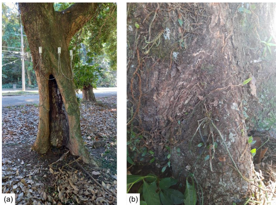
Figura 5: Defeitos encontrados na base das mungubas MG2 (a) e MG3 (b).
