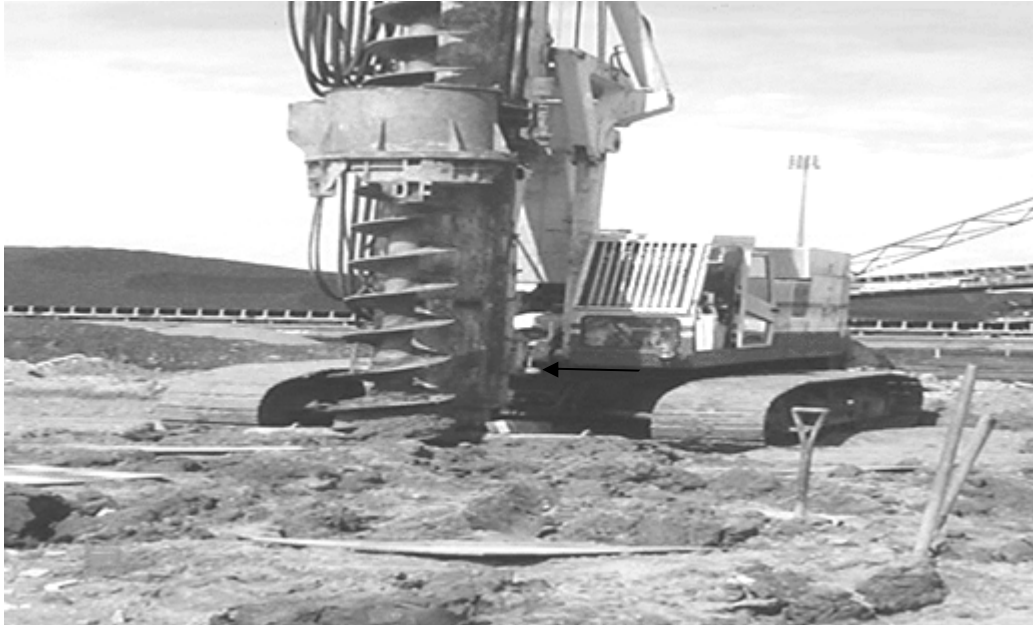
Figura 1. Retirada de solo para a construção das colunas de brita no pátio de minério da CSN no Porto de Itaguaí-RJ.
