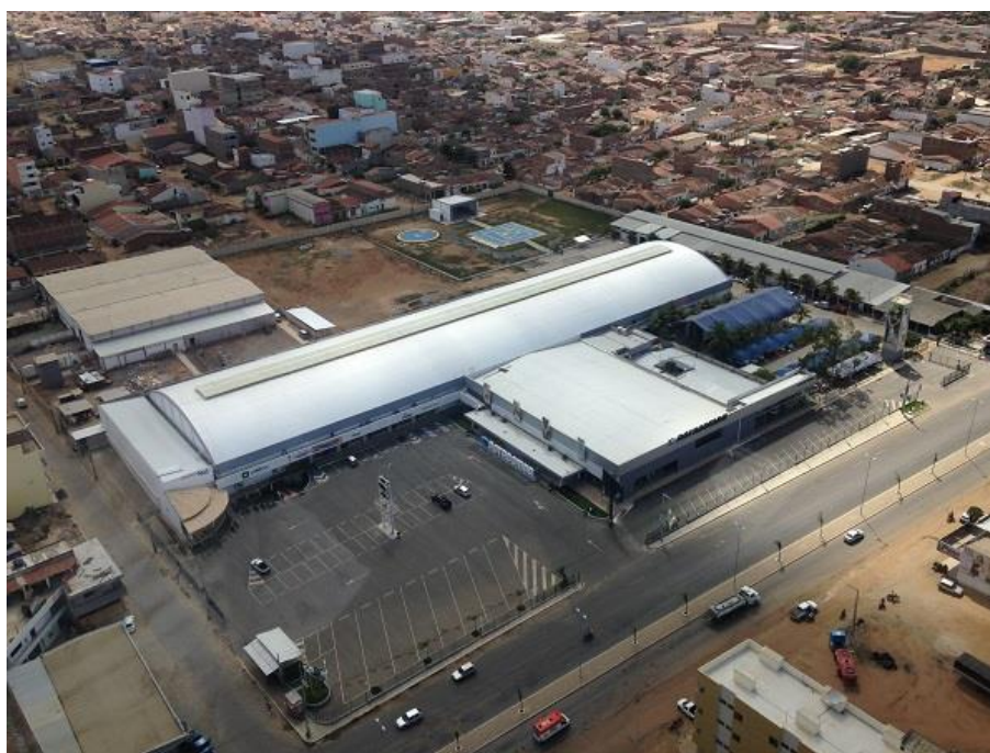
Figura 10: Vista aérea da Rota do Mar
