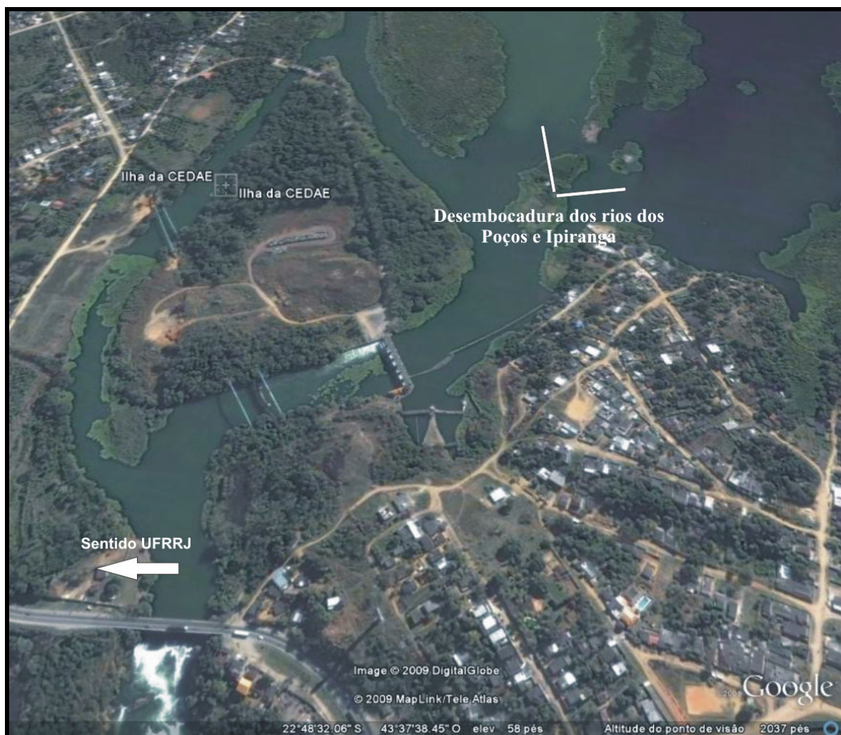
Figura 1. Foto de satélite do rio Guandu, mostrando a ponte da antiga estrada Rio – São Paulo (BR-465), a ilha da CEDAE e a barragem da estação de tratamento de água do Guandu (ETA).
