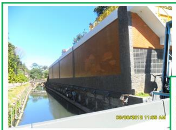
Estação Tratamento Esgoto - Quitandinha
