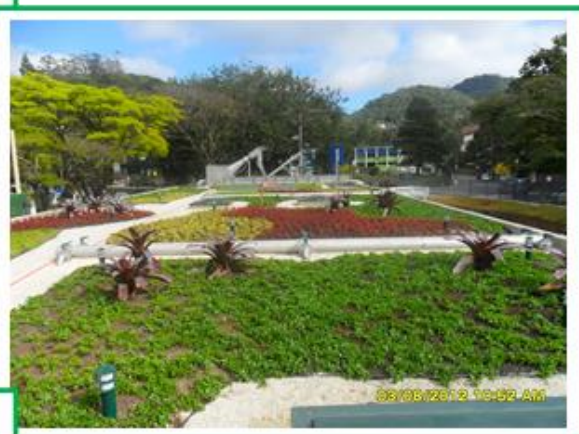
Estação Tratamento Esgoto - Piabanha
